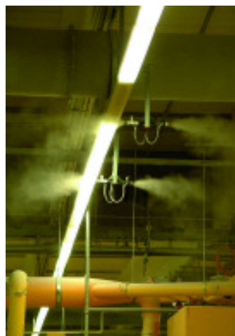
Eine optimale Luftfeuchte verhindert elektrostatische Aufladungen und Materialverzug
