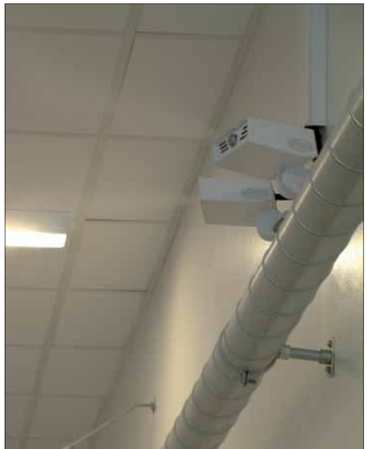
Abb. 3: Direkt-Raumluftbefeuchter von DRAABE versprühen tropfenfrei einen mikrofeinen Nebel.
