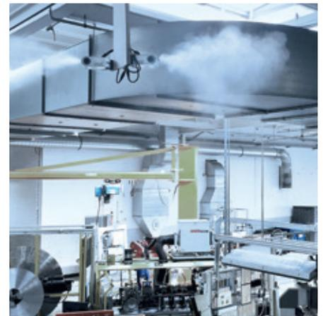
Hochdruck-Luftbefeuchter sorgen für angenehmes Klima in der Wärmetauscher-Fertigung
