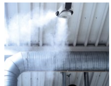
Die Vernebler vom Typ TurboFog versprühen bei Bedarf einen mikrofeinen Nebel
