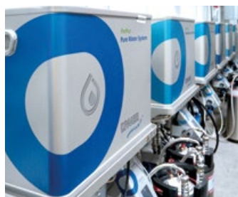
Mehrstufige Wasseraufbereitung der Hochdruck-Luftbefeuchtung
