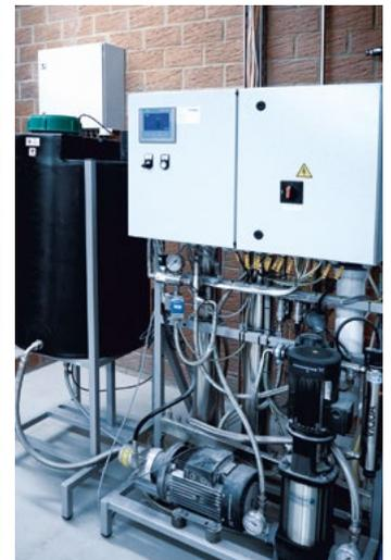
Wasseraufbereitung und Hochdruckpumpe des Condair ML Systems
