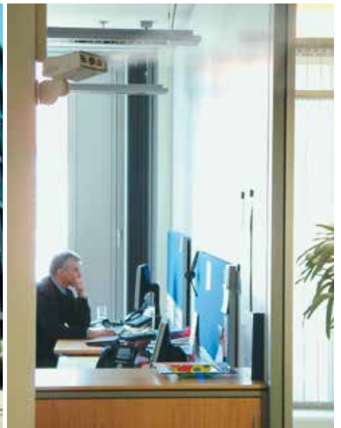
Die Direkt-Raumluftbefeuchter wurden nachgerüstet.
