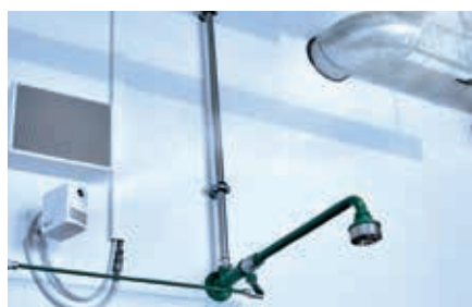
Der Direkt-Raumluftbefeuchter DRAABE NanoFog gibt bei Bedarf einen feinen Nebel in die Labore
