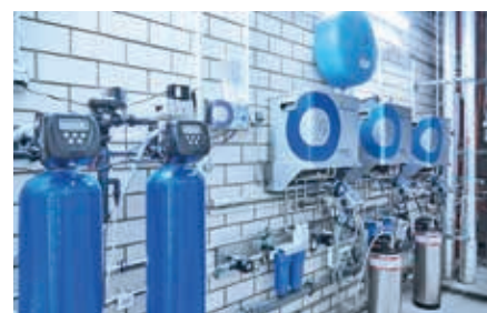
Die mehrstufige Wasseraufbereitung garantiert eine sichere und keimfreie Luftbefeuchtung
