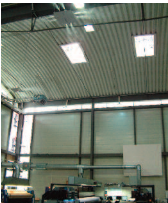
Der Draabe TurboFog 32 ist bei PPS als Deckensystem im Einsatz.
